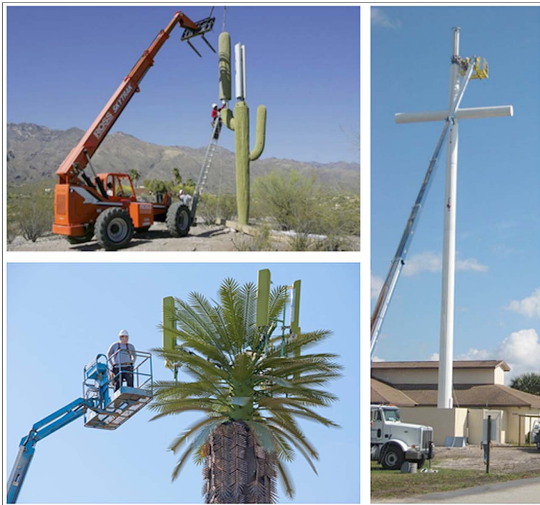
4. ábra Adott környezetbe illő, álcázott multifunkcionális toronyok
