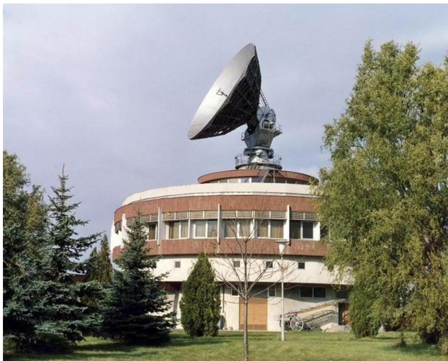
Taliándörögdi űrtávközlési földi állomás, ahol a műholdra továbbított, illetve onnan érkező távbeszélő csatornák jeleinek feltöltését és lebontását a TKI fejlesztésű és gyártású INTERCSAT berendezés biztosította. A beszédcsatornák jeleit és esetenként TV képet a TKI és Orion közös fejlesztésű, GTT 8000 típusjelű, 8 GHz-es, 960 távbeszélő csatorna, vagy színes TV kép és négy kísérőhang átvitelére szolgáló berendezések továbbították a Dunántúli Hálózat Győr-i főállomására. Innen a nyugati lánc berendezései biztosították az összeköttetést a taliándörögdi állomás és a Széchenyi-hegyi TV adó épületében lévő Országos Mikrohullámú Központ vagy Taliándörögdi és Bécs között.
