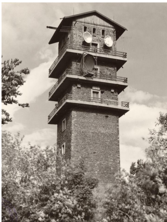
A kékestetői torony 1953-ban. Ennek alsó teraszára szerelték fel a TKI és a torony közötti első, huroküzemben működő mikrohullámú összeköttetés antennáját, míg az adóvevő berendezést a mögötte lévő helységben helyezték el. A TKI egy antennát használt vételre és adásra. (Fotó: a Postamúzeum gyűjteményéből)
